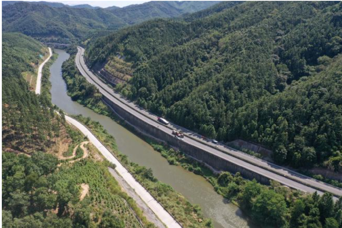
图 2.挡墙段航拍图
