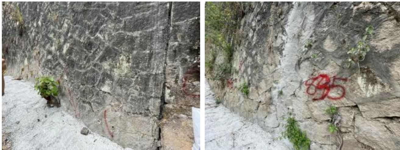
图 9、10. 墙脚起皮松动
